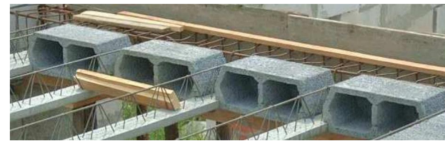
Рис. 3. Конструкція збірно-монолітного перекриття «TERIVA»
