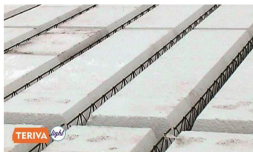
Рис. 15. Перекриття системи TERIVA з пінополістирольними блоками
