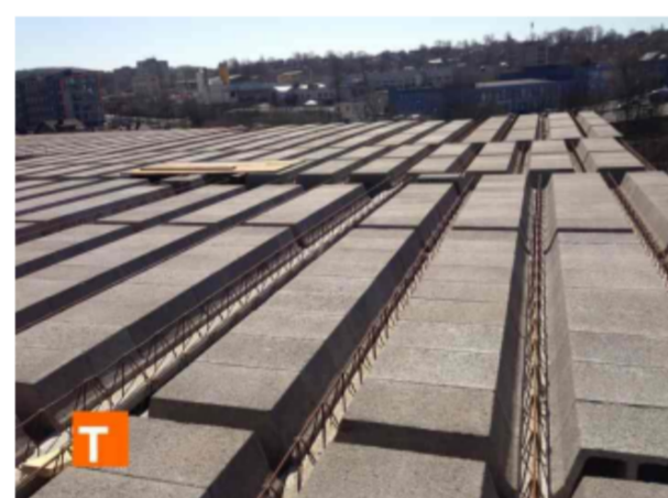
Рис. 14. Перекриття системи TERIVA з керамзитобетонними пустотними блоками
