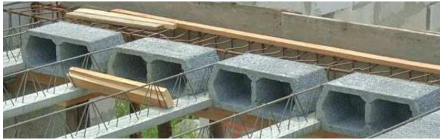
Рис. 10. Конструкція збірно-монолітного перекриття «TERIVA»
