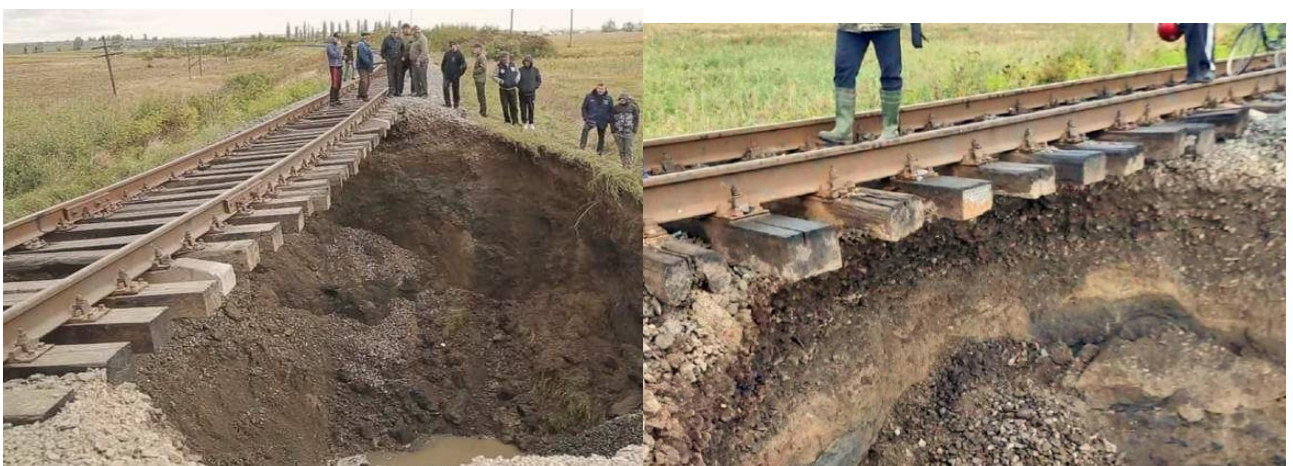
Рисунок 2.4 – Ерозія ґрунту під залізничною колією на Буковині
