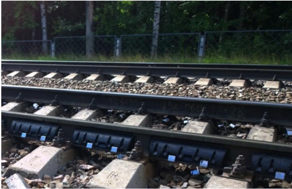
Рисунок 4.1 – Вібродемпферна накладка на шийку рейки
