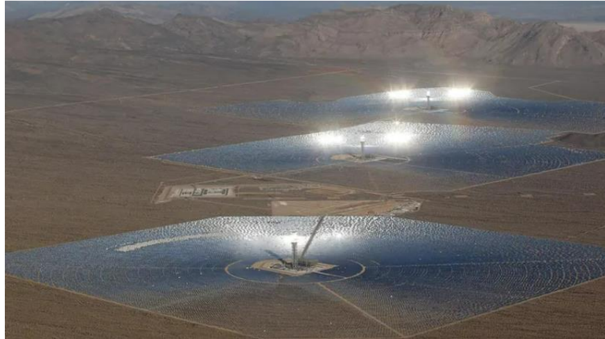
Рисунок 3.1 – Іванпах сонячна електростанція
