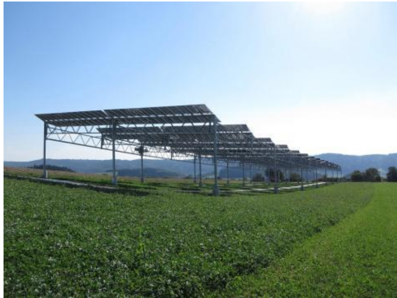
Рисунок 3.5 – Сонячні панелі на висоті 5 м
