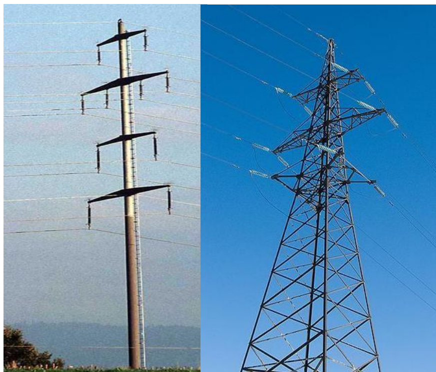
Рисунок 1.1 – Проміжна та анкерна опора
