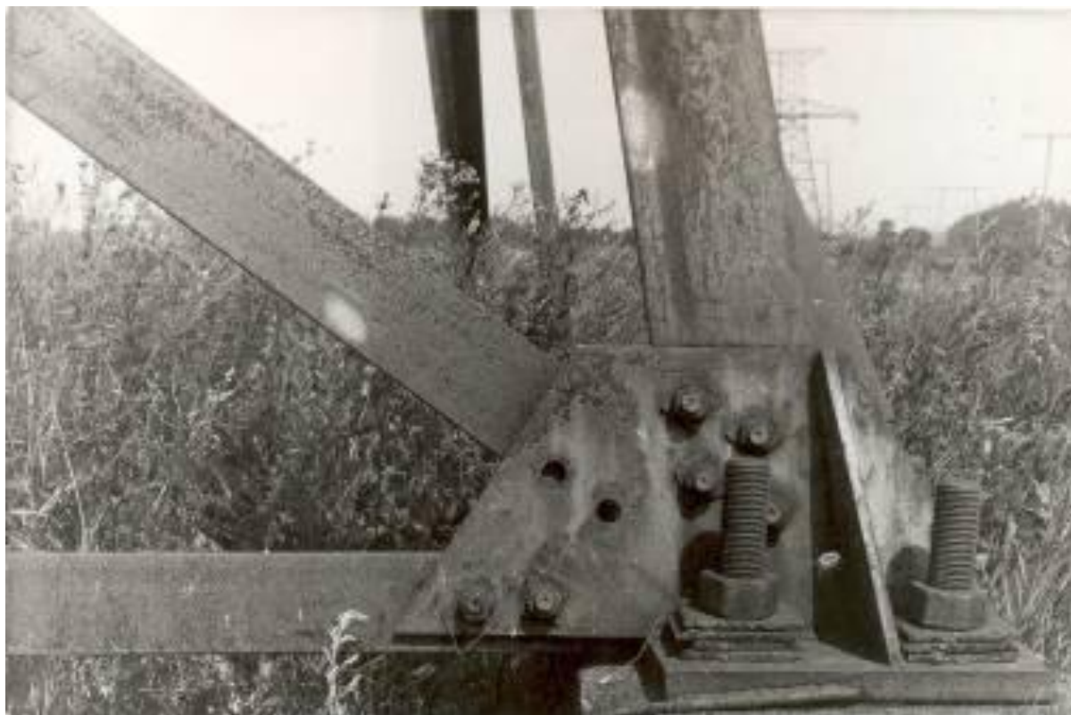
Рисунок 2.1 – Зачищена пляма для вимірювання корозійних втрат товщини
