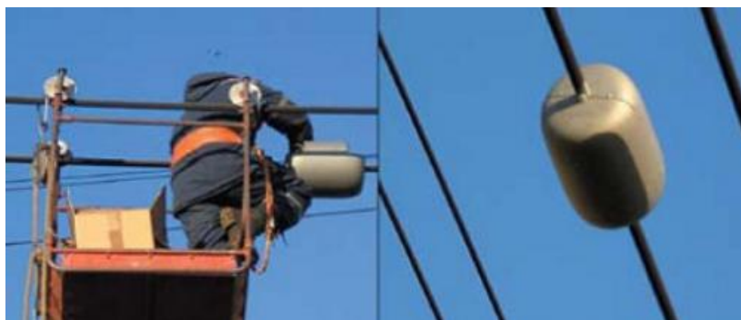
Рисунок 4.10 – монтаж вимірювального блока на проводах ЛЕП
