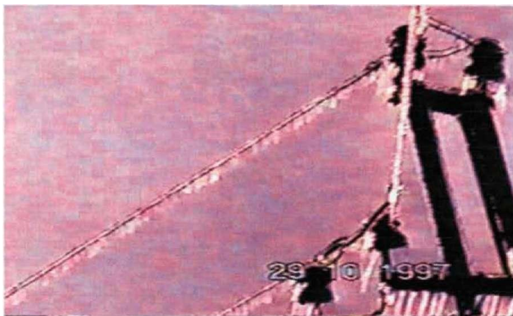
Рисунок 3.9 - Зігнута опора під навантаженням ожеледиці
