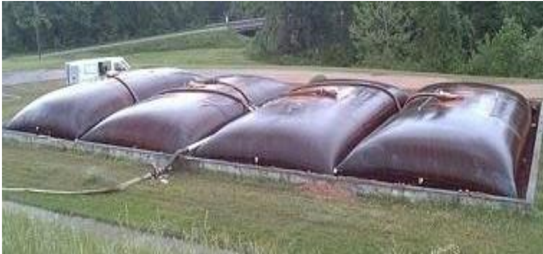
Рисунок 5.9 - Створення ділянки для зневоднення річкового мулу.
