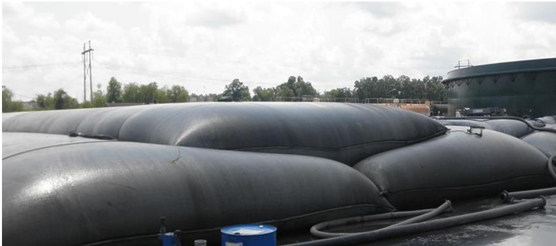
Рисунок 5.10 - Зневоднення та зберігання відкладень у геотубах.
