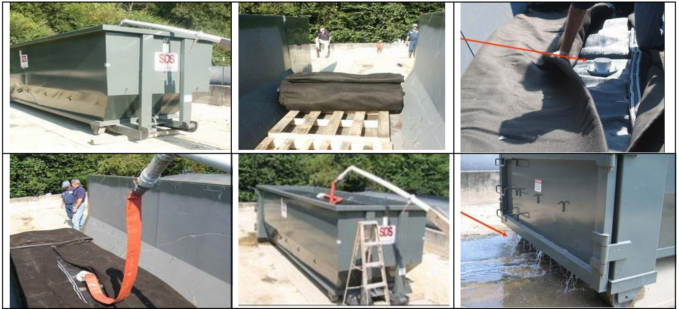
Рисуноу 5.11 - Використання мобільного контейнеру для завантаження, транспортування донних відкладень і тимчасового зберігання у геотубах
