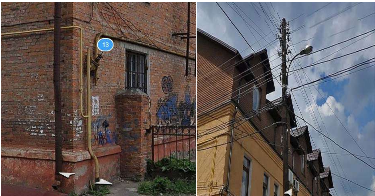
Рисунок 4.13 – Стан інженерного забезпечення
