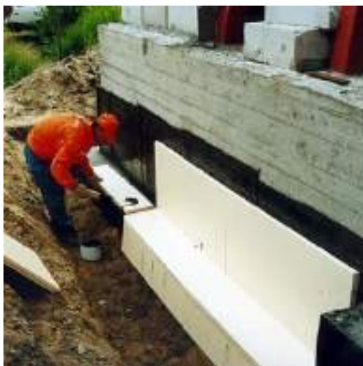
Рисунок 1.11 – Влаштування теплоізоляцій бічної поверхні фундаменту [12]
