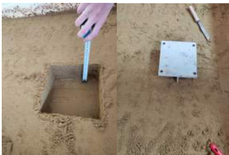
Рисунок 2.8 – Підготовка котловану і розміщення моделі фундаменту у ґрунті при глибині закладання 0,5 b
