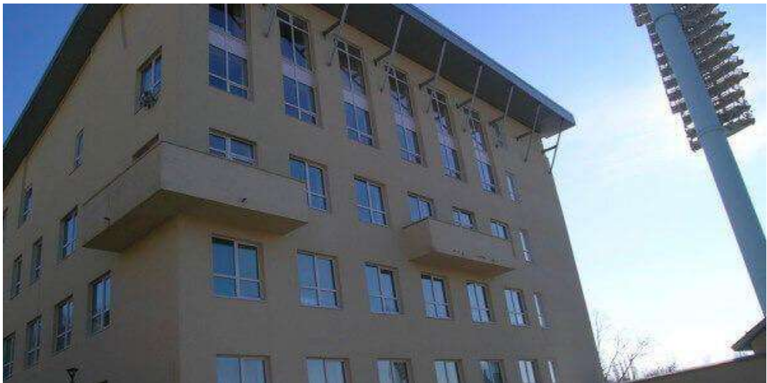
Рисунок 3.3 – Lucky.Net Telecom Office
