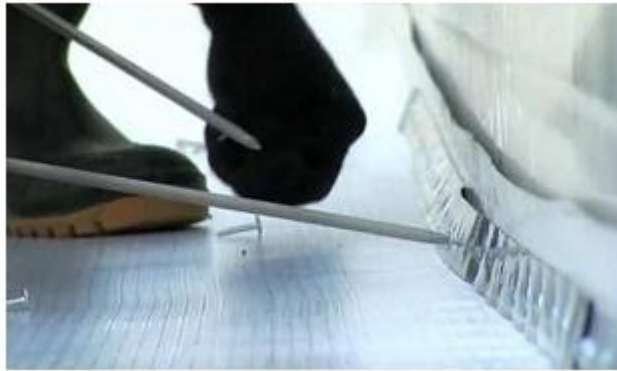
Рисунок 4.5 - Монтаж притискної планки до паркету
