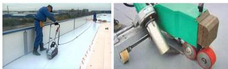
Рисунок 4.3 - Зварювання полотнищ мембрани зварювальним апаратом
