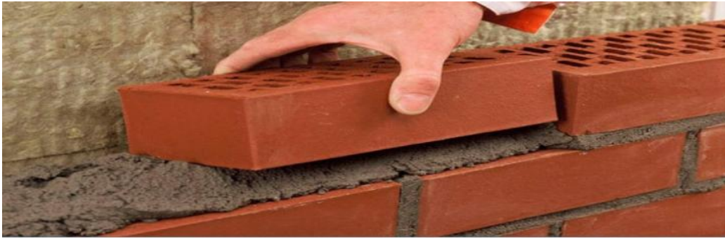
Рисунок 2.3. Цегляна кладка перегородок
