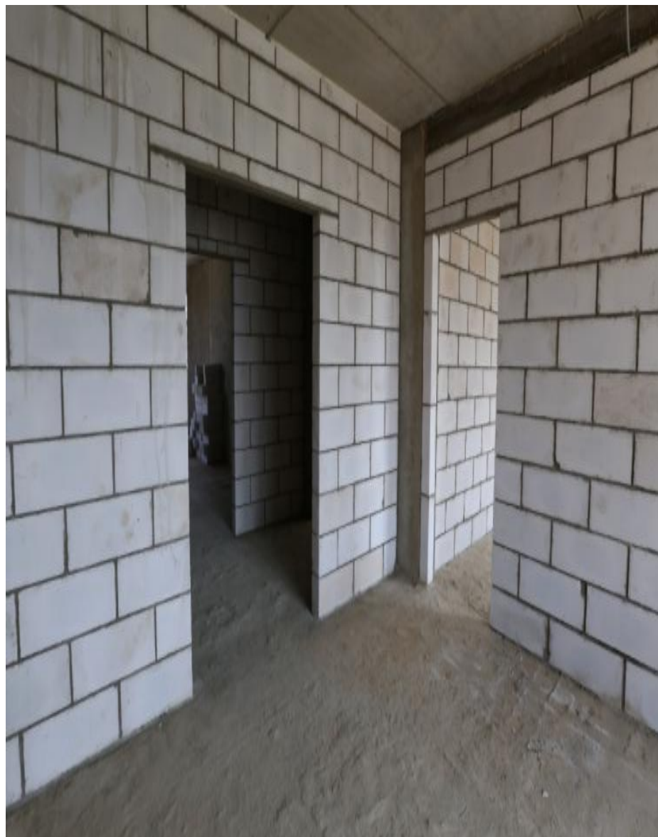
4. З газобетонних блоків
