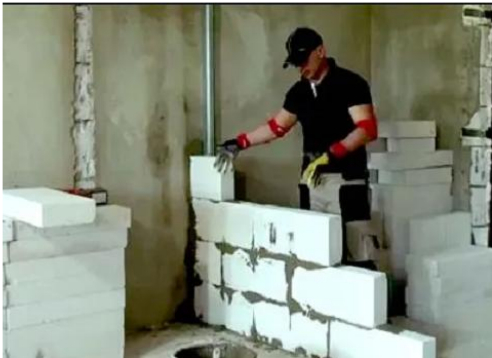
Рисунок 1.10 Закріплення міжкімнатної перегородки з блоків пористого бетону
