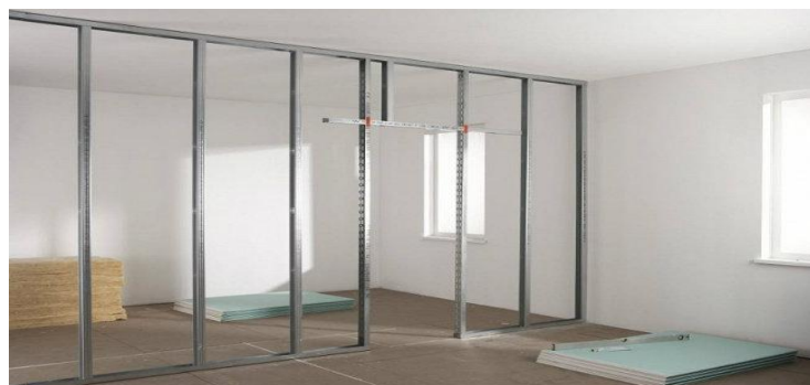
Рисунок 2.2 Каркас з металевого профілю для міжкімнатних перегородки з гіпсокартону
