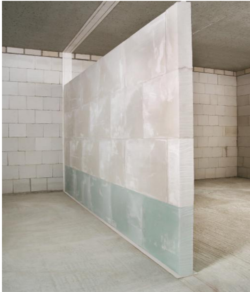
Рисунок 1.9 Перегородка з пазогребневих плит
