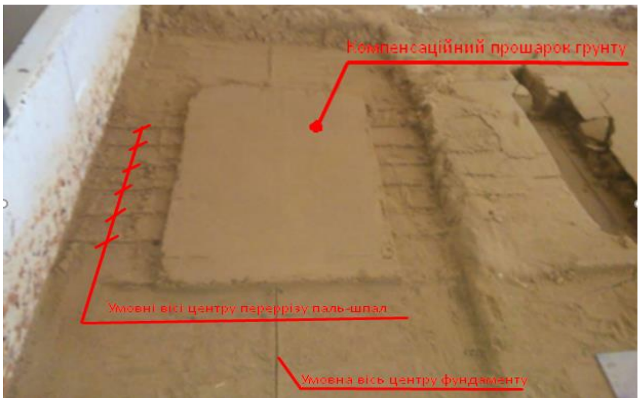
Рисунок 2.7 - Влаштування компенсаційного прошарку ґрунту між верхніми гранями паль-шпал та підшовою моделі стрічкового фундаменту
