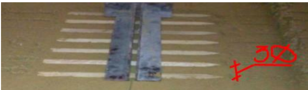
Рисунок 2.8 - Встановлення паль-шпал в виямки.
