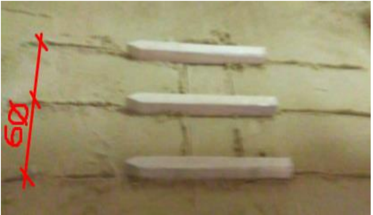
Рисунок 2.6 - Встановлення паль-шпал в виїмки.
