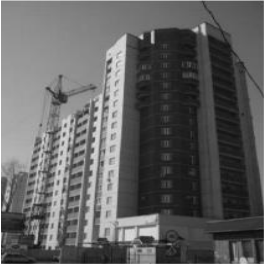
Рисунок 1.2 - Загальний вигляд секції, зведеної на основі, підсиленій шпальним розподільвачем. м. Воронеж вул. Чапаєва 2010 р.
