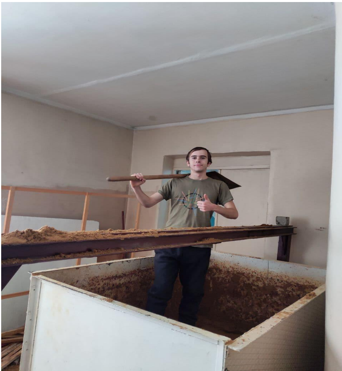
Рисунок 2.1 - Пошарове укладання піску в лоток з ущільненням кожного шару.
