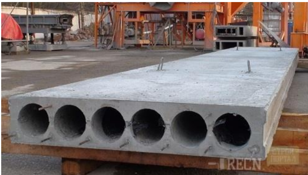
Рисунок 1.4 – Багатопустотна плита перекриття
