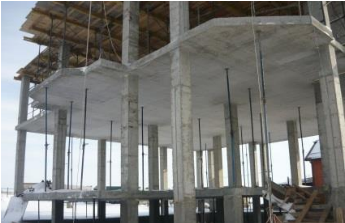
Рисунок 1.8 – Монолітне безбалкове перекриття
