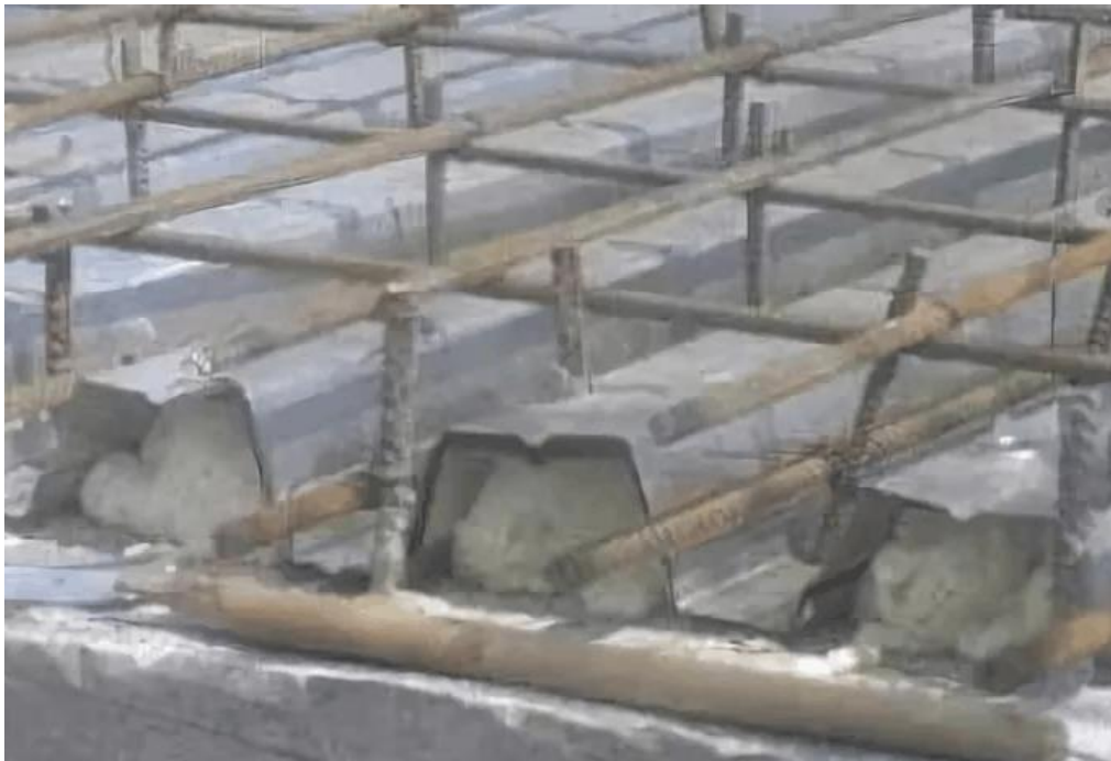
Рисунок 2.5– Армування перекриття по профнастилу
