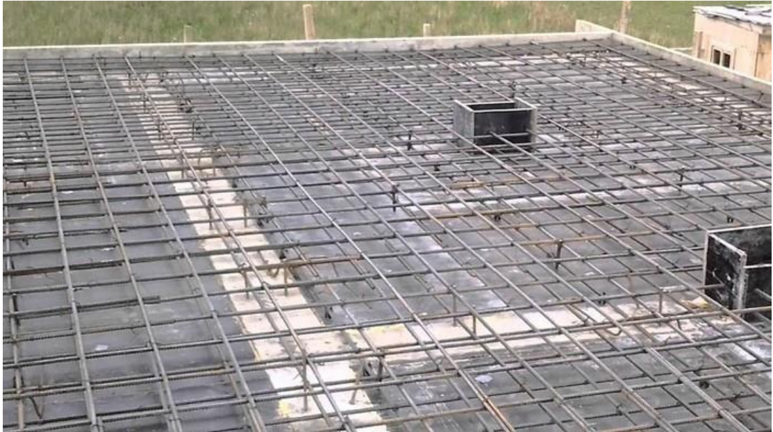
Рисунок 2.3 – Готовий арматурний каркас для бетонування монолітної плити
