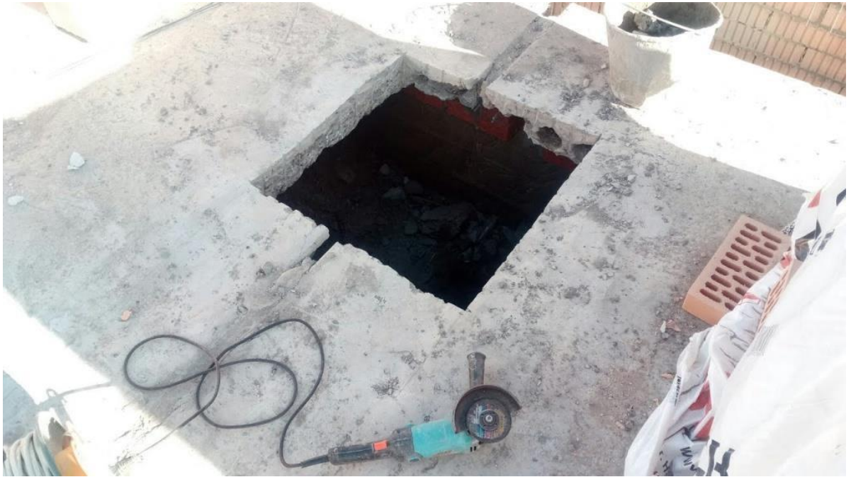
Рисунок 2.1 – Вирізання отвору в збірному перекритті
