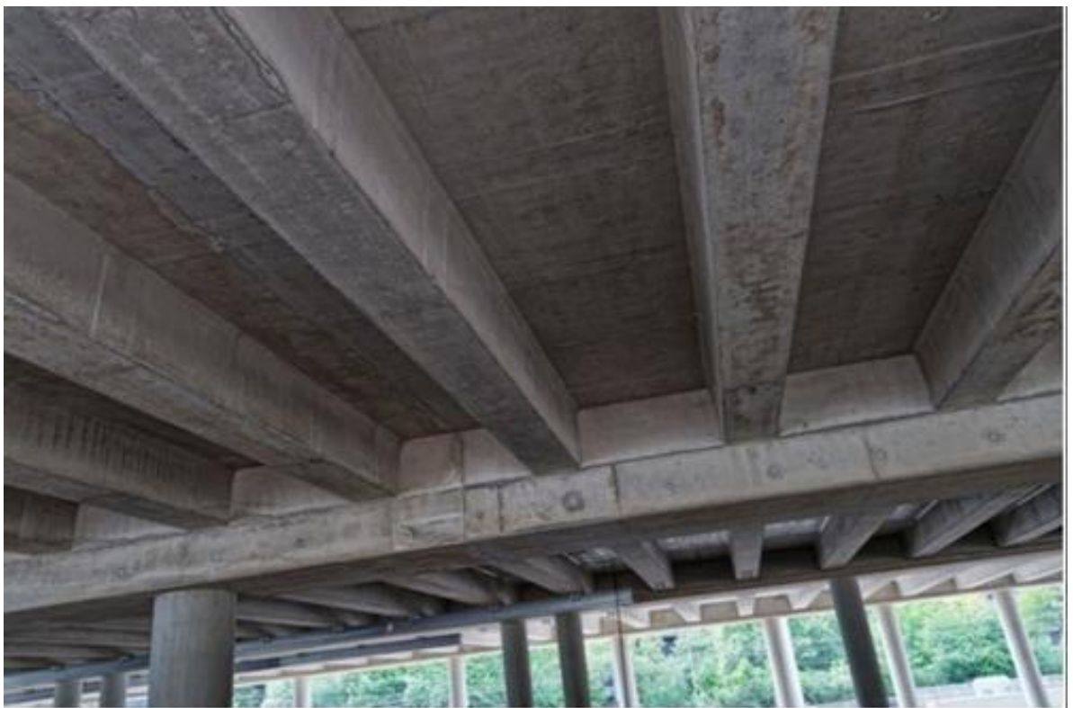
Рисунок 1.6 – Ребристе монолітне перекриття
