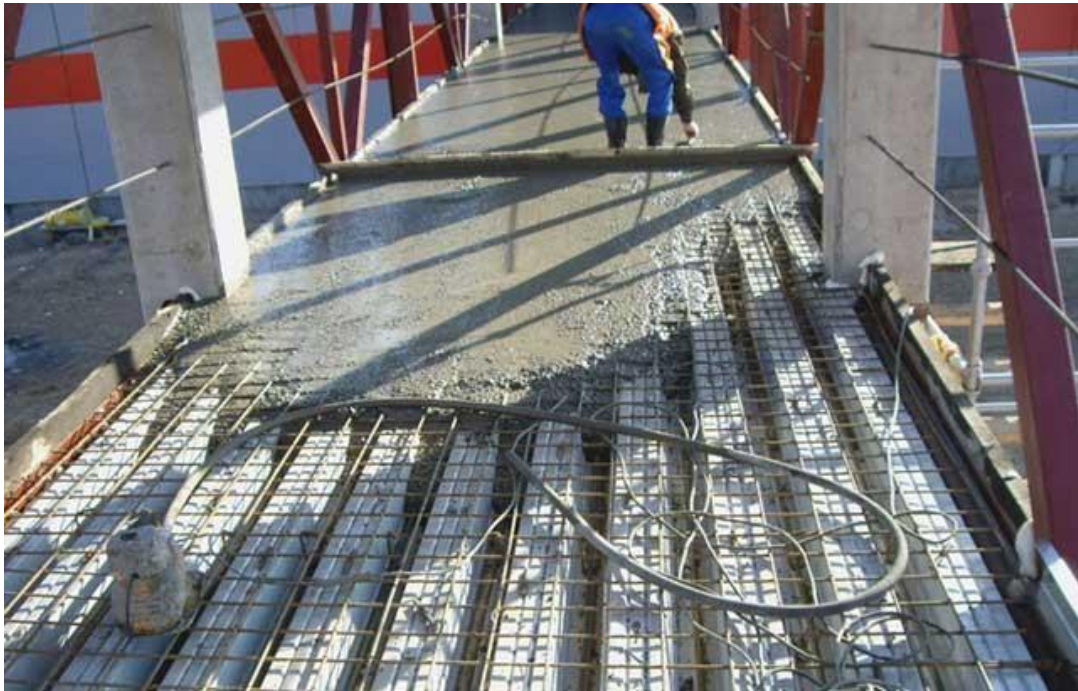
Рисунок 1.9 – Монолітне перекриття по профнастилу
