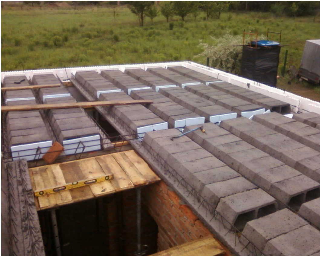
Рисунок 2.4 – Монтаж збірно-монолітного перекриття
