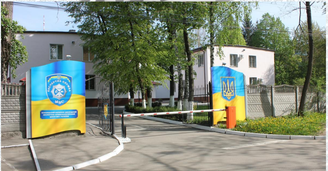
Рисунок 1.13 – Загальний вигляд будівель та входу Вінницького НДЕКЦ МВС України
