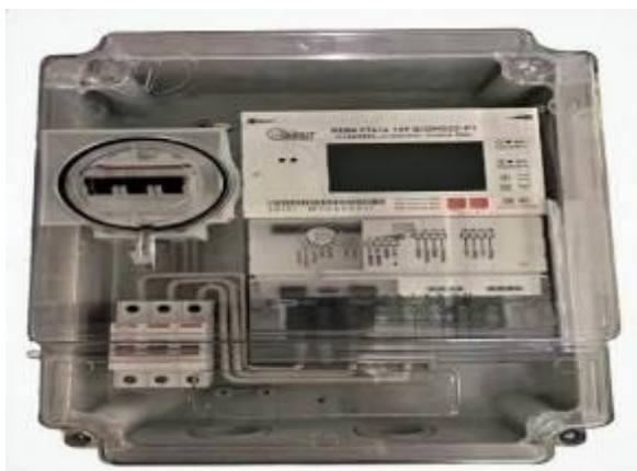
Рисунок 2.1 — Трифазний багатофункціональний лічильник НЕВА СТ414
