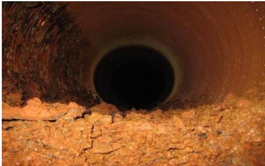
Рисунок 3.4 – Корозія в середині системи теплопостачання
