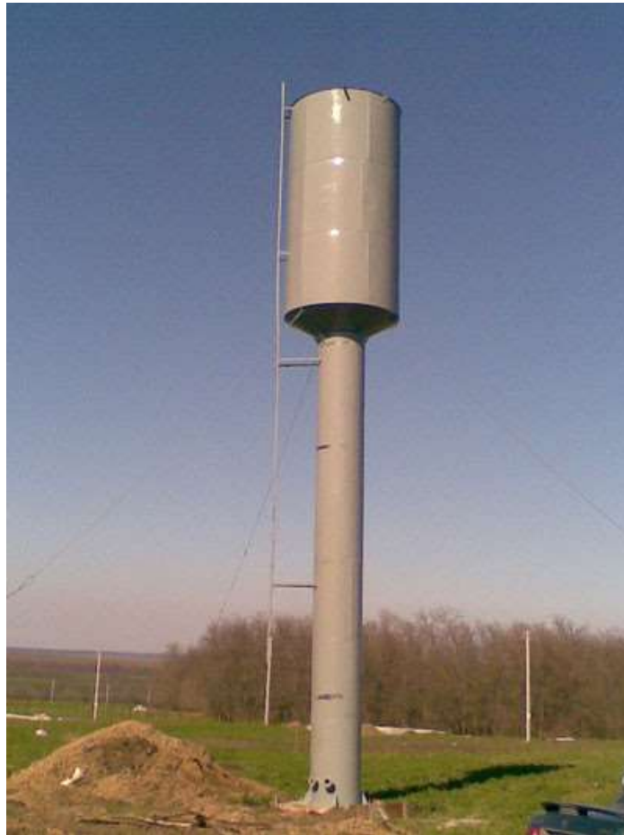
Рисунок 1.8 – Водонапірна башта Рожновського
