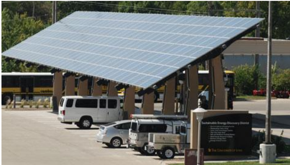
Рисунок 1.6 – Стоянка з фотоелектричною зарядною станцією біля University Services Building (США).
