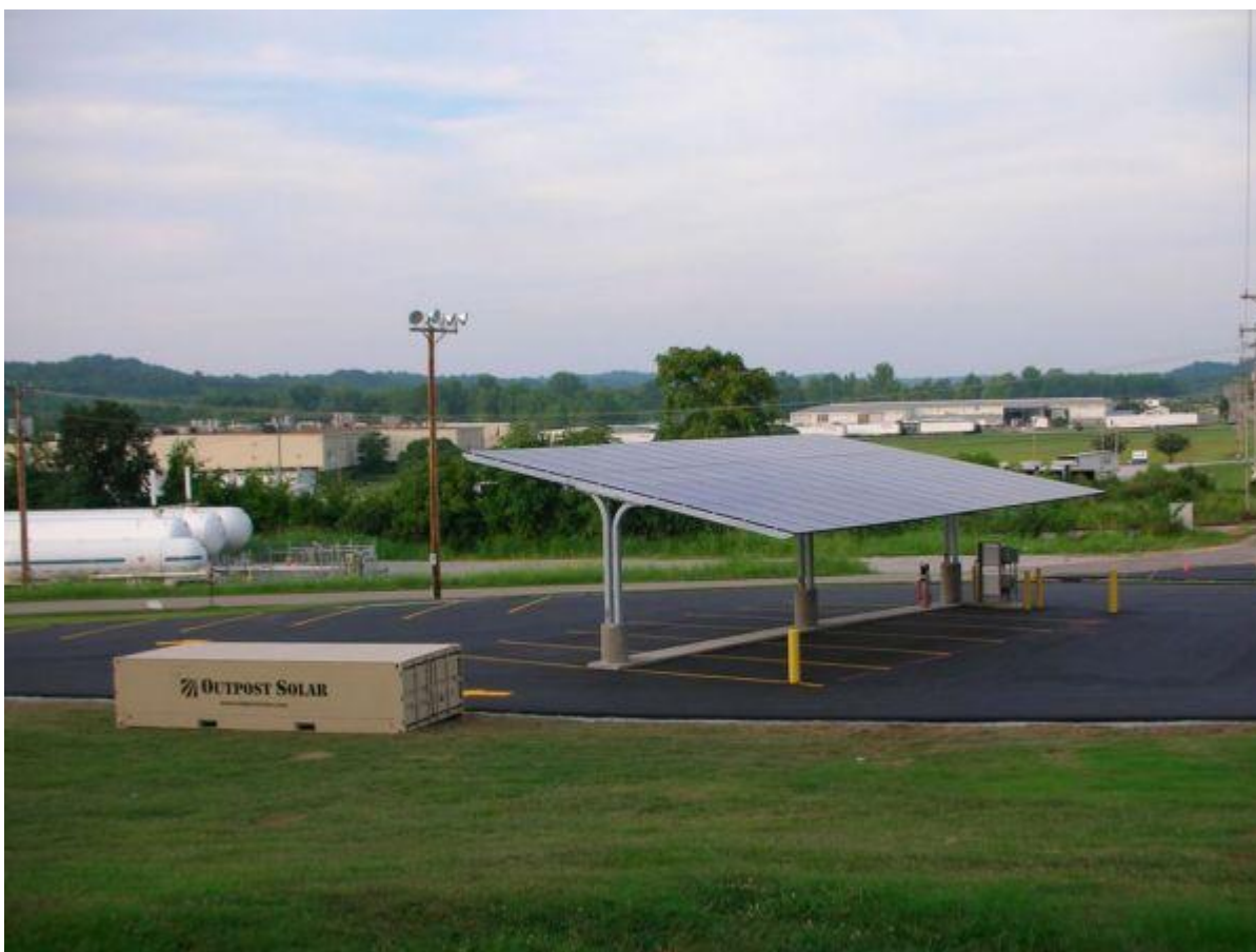
Рисунок 1.5 – Стоянка з фотоелектричною зарядною станцією
