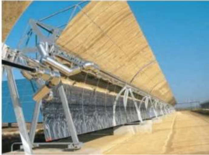
Рисунок 1.11 – Довгі параболічні (в поперечному перерізі) дзеркала з трубами для розігрівання теплоносія
