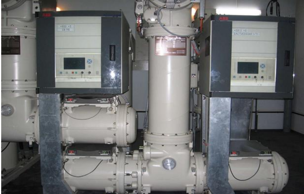
Рисунок 6.3.3 – Цифрові пристрої керування КРУЕ
