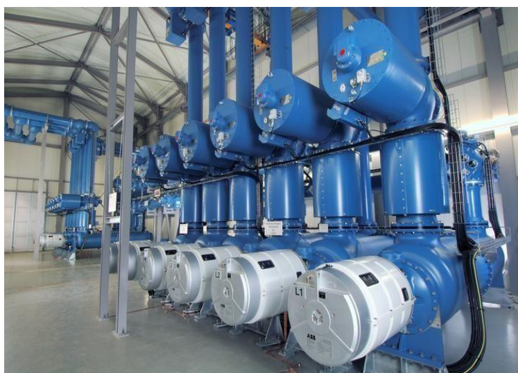
Рисунок 5.3.1 - КРУЕ до 550 кВ серії ELK3 (АВВ)
