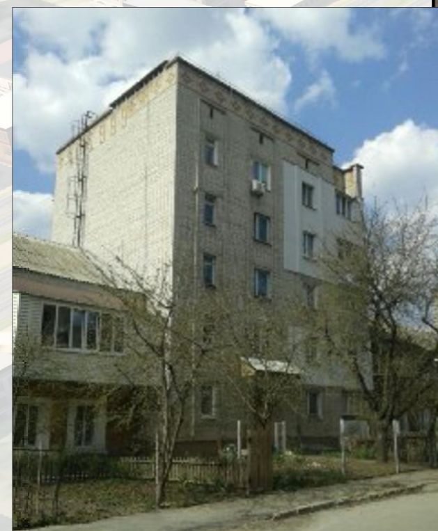
Житловий будинок вул. П. Тичини, 4а
