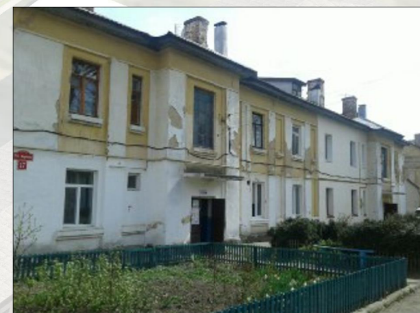
Технічний стан будинку №17 по вулиці М. Зерова
