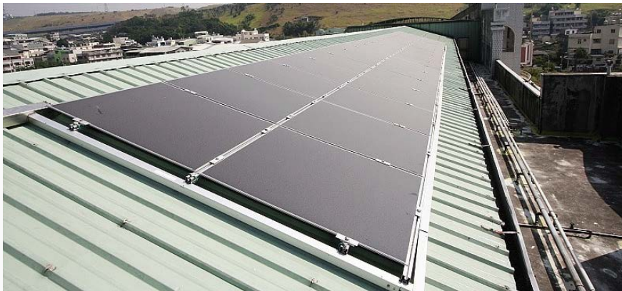
Рис 3.4.10 Фотоелектричні модулі з аморфного кремнію
