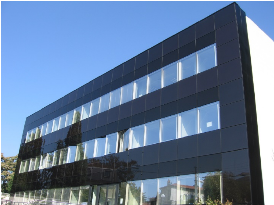
Рис. 3.4.14 Фасад з інтегрованими тонкоплівковими сонячними модулями
