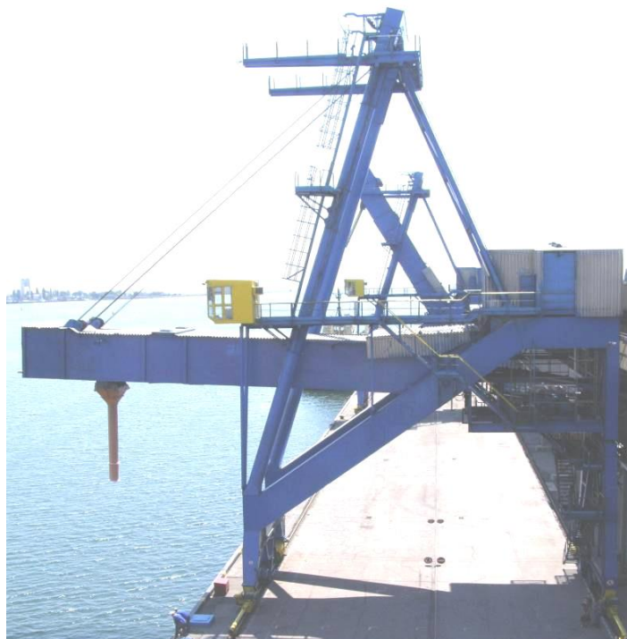
Рис. 2.3 – Загальний вигляд суднонавантажувача № 7.1 з північного боку (висувна частина всередині стріли, стріла – горизонтальна)
