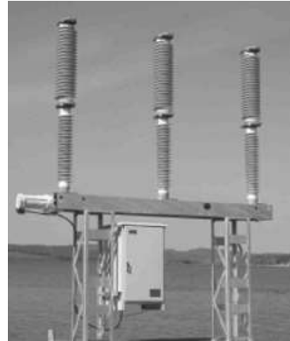
Вимикач типу LTB з електроприводом Motor Drive™ компанії ABB
