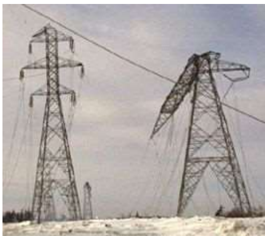
Рисунок 1.5 – Пошкодження опори повітряної лінії в результаті дії ожеледі
