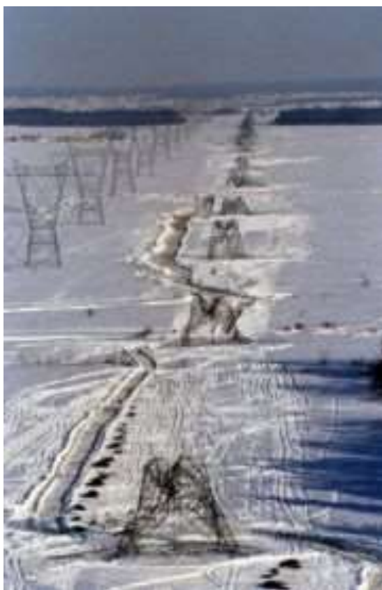
Рисунок 1.6 – Каскадне пошкодження ЛЕП при ожеледі
