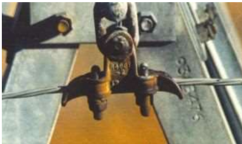
Рисунок 1.7 – Підтримуючий зажим з слідом корозії
