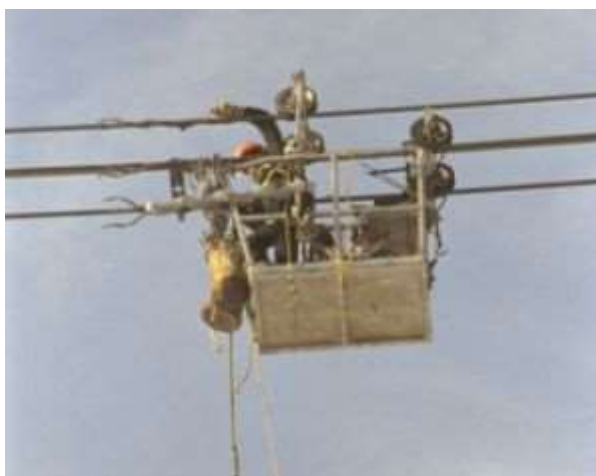
Рисунок 1.4 – Ремонт проводів на повітряній лінії
