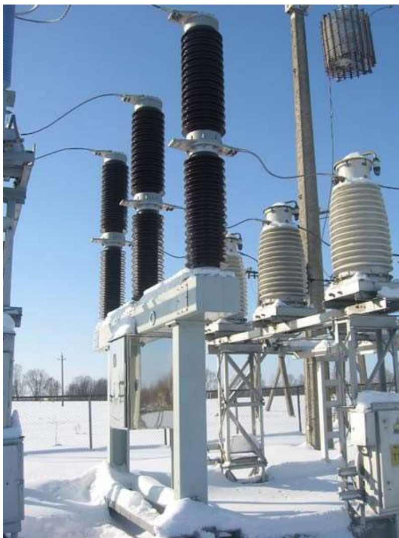
Рисунок 1.1 –Елегазовий вимикач 110 кВ
