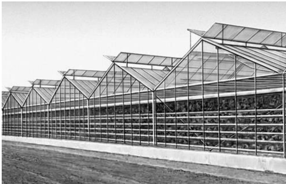
Рис. 1.2 – Розміщення дахових фрамуг в блочній теплиці
