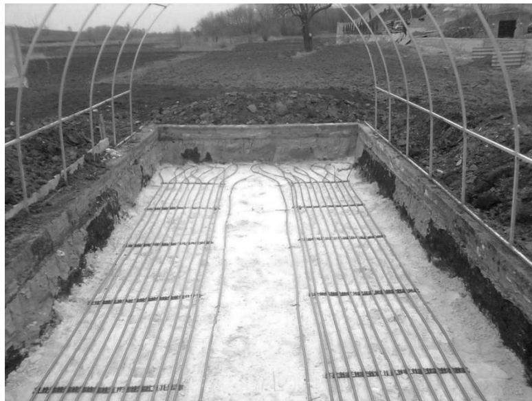
Рис. 1.1 – Водяний обігрів ґрунту в теплиці
