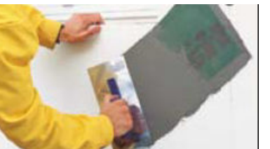
Додаткове укріплення захисного шару в умовах віконних і дверних прорізів
