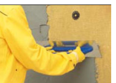
Укладання армуючої склосітки
