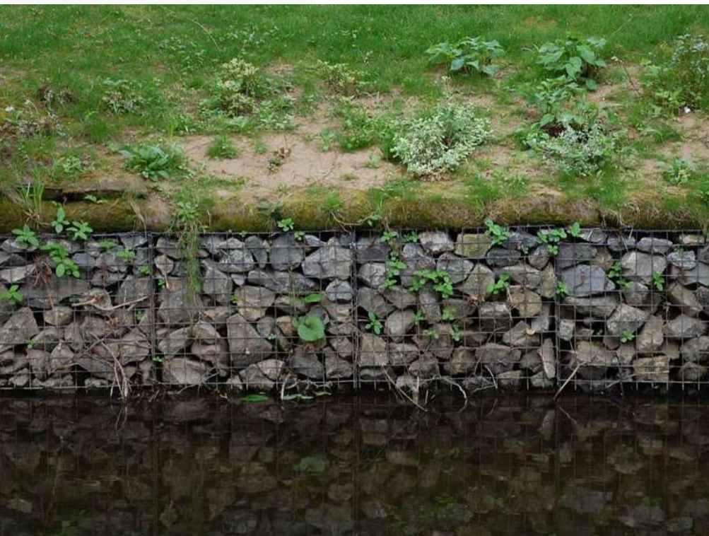
Укріплення берегів габійними конструкціями
