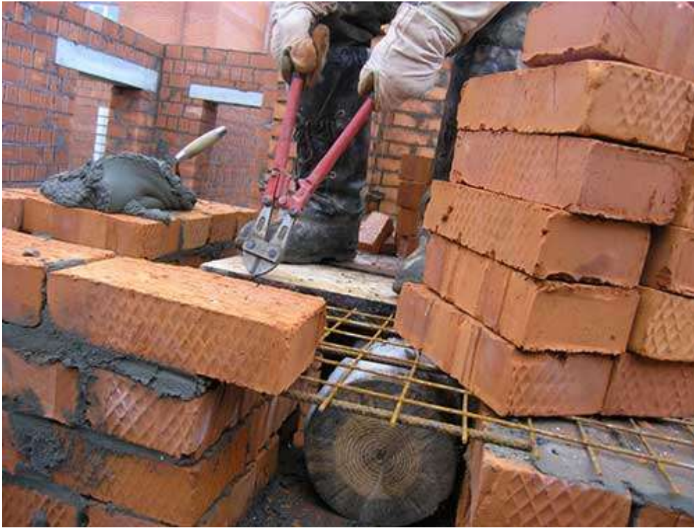
Мурування перегородок армованих товщиною в 1/2 цегли
