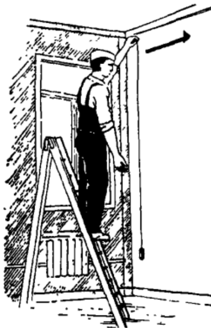
Рисунок 3.2 – Провішування стін у кутах
