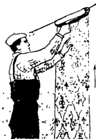
Рисунок 3.3 – Розгладжування шпалер валиком
