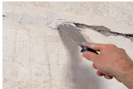
Заповнення тріщин шпаклівкою
