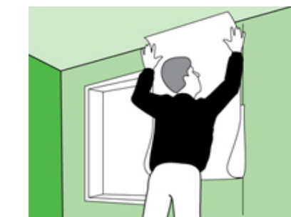
Приклеювання полотнищ до стіни
