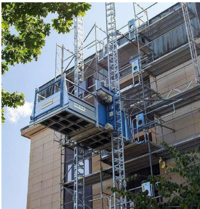
Рисунок 3.1 – Щогловий підйомник типу Geda 1500Z/PZ
