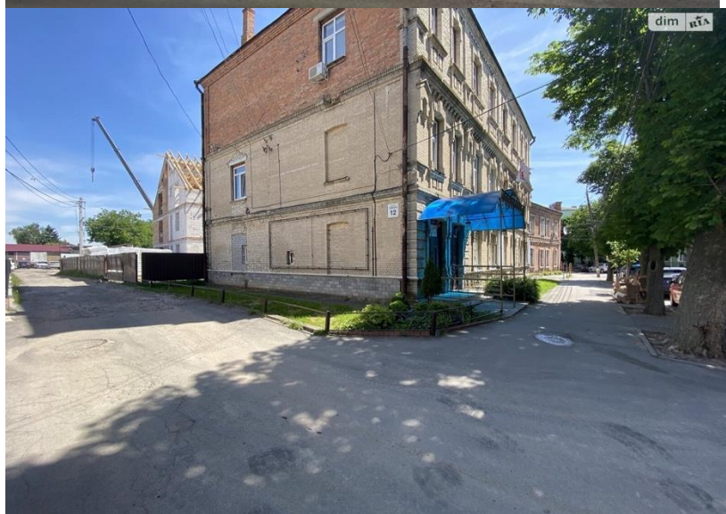
Рисунок 3 – Екстер'єр будівлі для відкриття соціального кафе «Горнятко добра» а) вигляд з вулиці Грушевського, 12; б) вигляд у внутрішній дворик, де планується літня тераса
