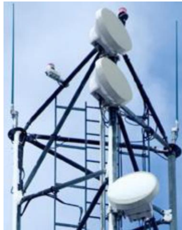
Рисунок 3.10 – Вигляд виносної підсистеми Ericsson Mini Link
