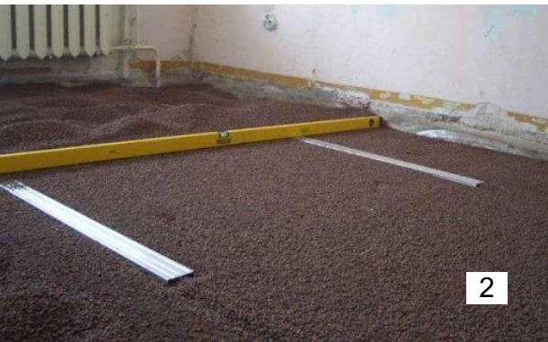
Улаштування ізоляції засипної керамзитової
