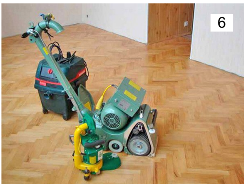
Влаштування покриття з штучного паркету та його шліфування
