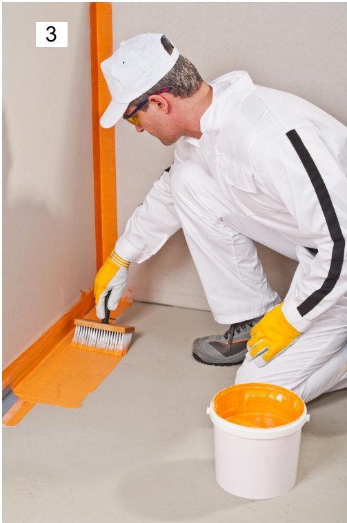
Улаштування гідроізоляції
