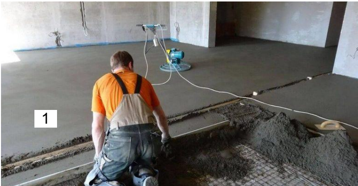
Влаштування цементної стяжки
