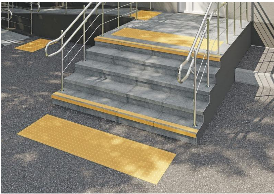
Рис. 1 Приклад маркування сходів контрасною смугою та тактильною плиткою
