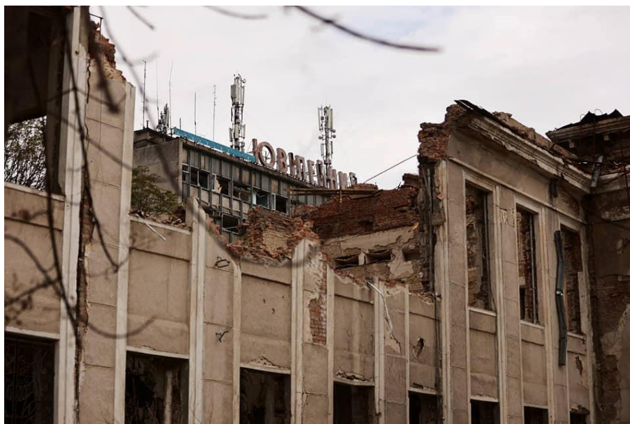
Рис. 2.3 Стан існуючих зовнішніх стін
