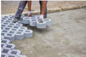
Влаштування бетонних решіток
