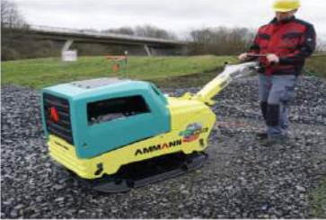
Ущільнення поверхні щебеню віброплитою
