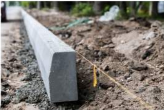
Влаштування бордюрного каменю
