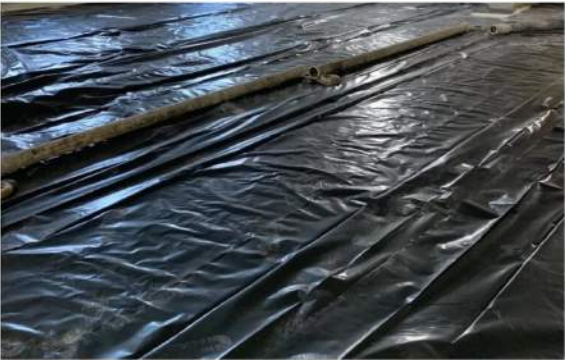
Улаштування гідроізоляції
