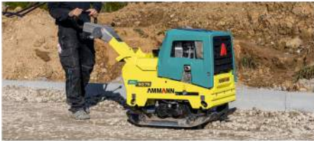
Ущільнення поверхні земляного полотна віброплитою
