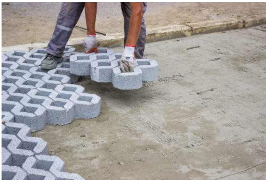
Рисунок 3.2 – Укладання газонних решіток
