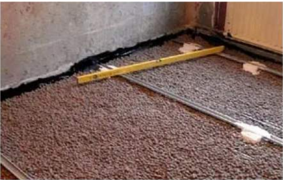
Влаштування основи зі щебеню з ущільненням
