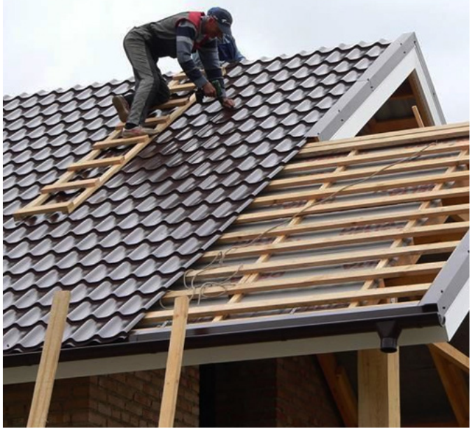
Улаштування покрівель металочерепиці 'Монтерей'
