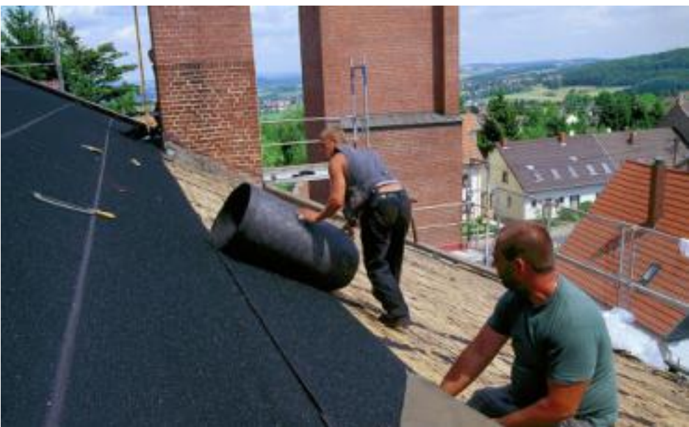
Улаштування обклеювальної гідроізоляції рулонними матеріалами на мастиці
