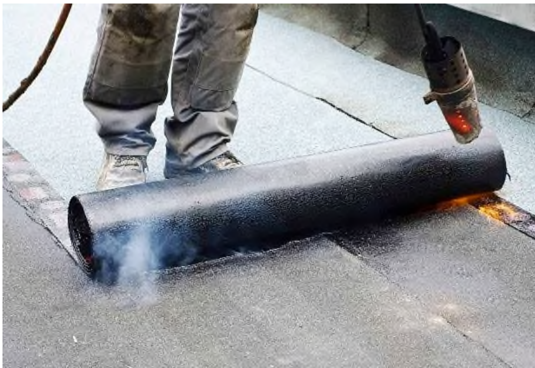
Влаштування гідроізоляції
