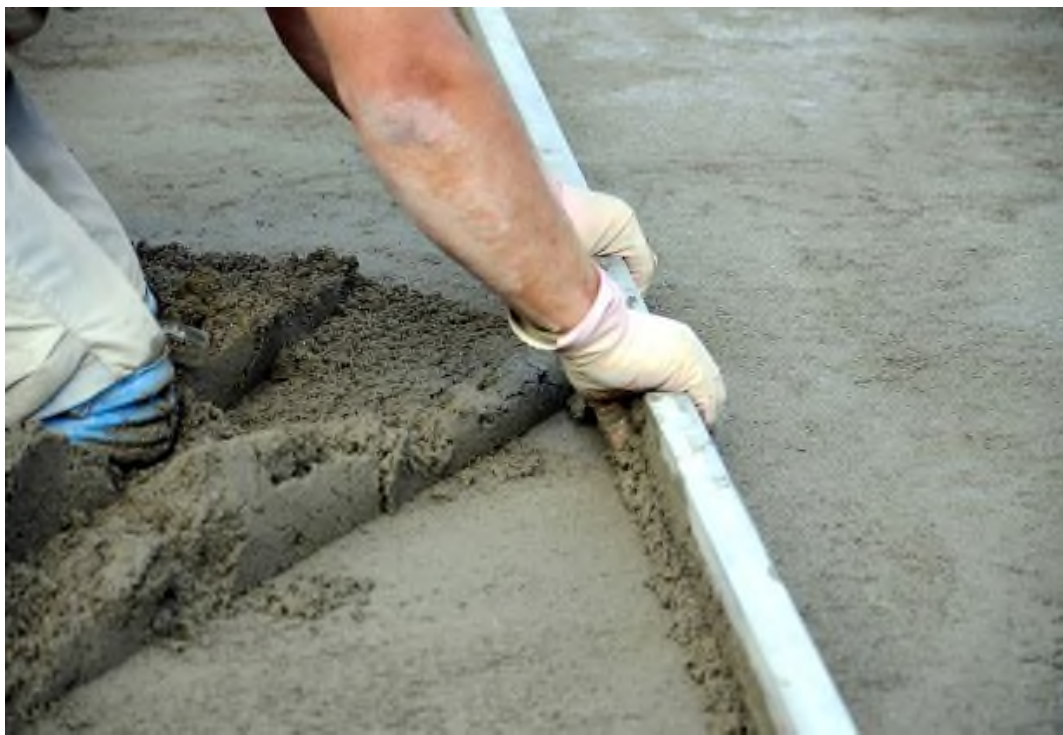
Влаштування цементно-піщаної стяжки
