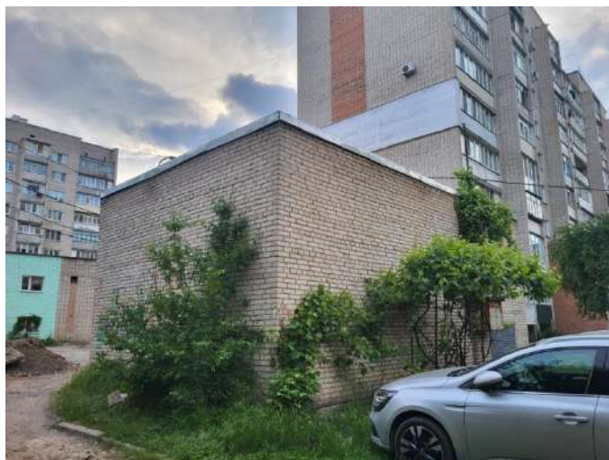
Рисунок 1.4 – Центральний тепловий пункт
