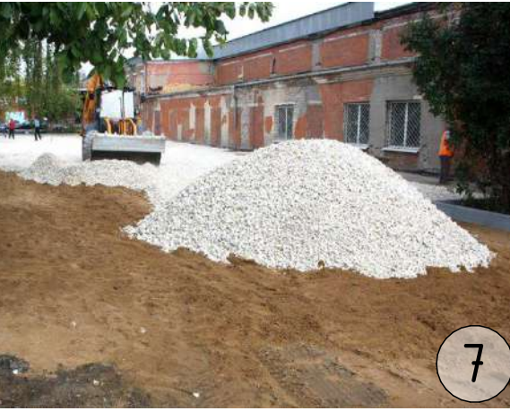
Ущільнення ґрунту щабелем
