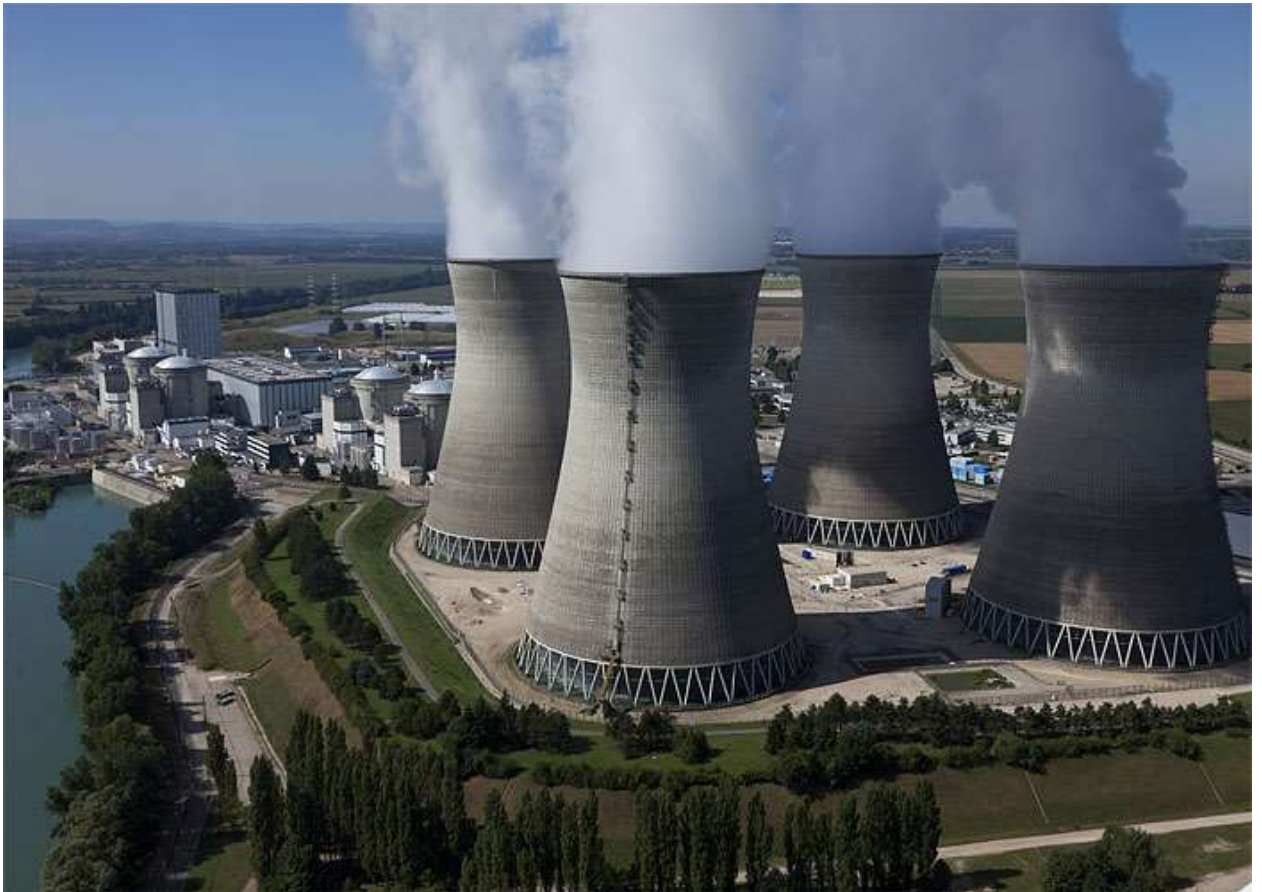
Рисунок 2 – Енергетика Франції: атомна електростанція Бюже
