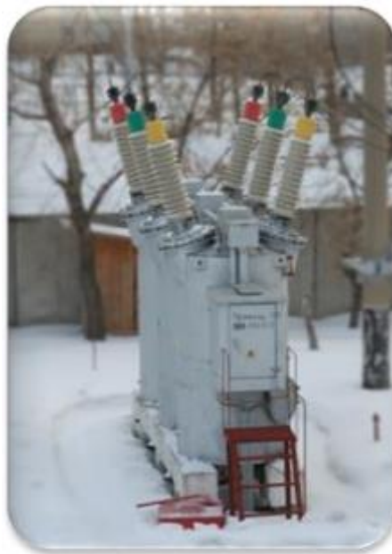
Рисунок 2.5 – Масляний вимикач
