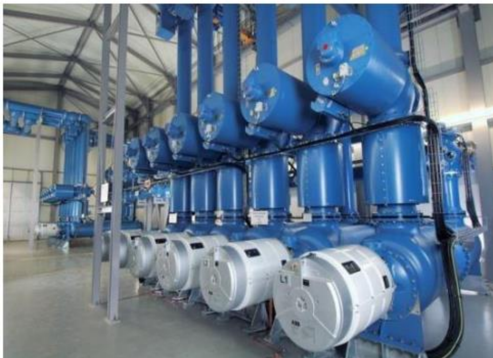
Рисунок 3.2 - Газоізолюваний розподільний пристрій із елегазовою ізоляцією до 550 кВ серії ELK3 (ABB)
