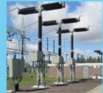
Елегазовий вимикач
