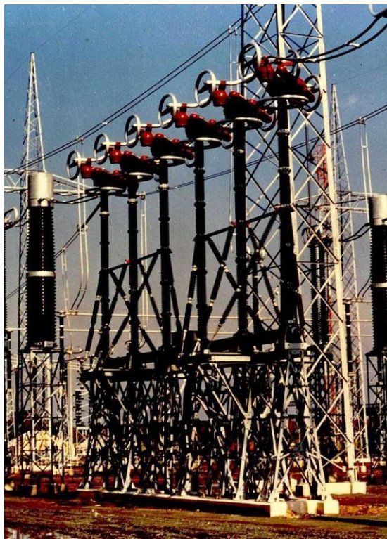
Рисунок 2.6 – Повітряні вимикачі
