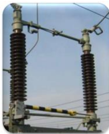
Рисунок 2.7 – Зовнішній вигляд роз'єднувача
