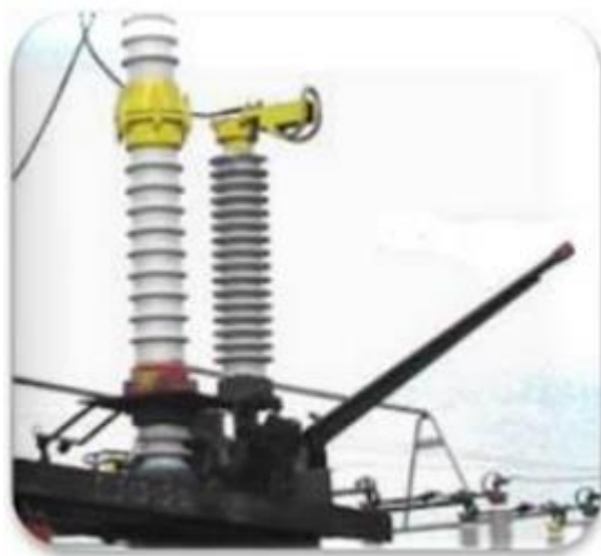
Рисунок 2.8 – Короткозамикач
