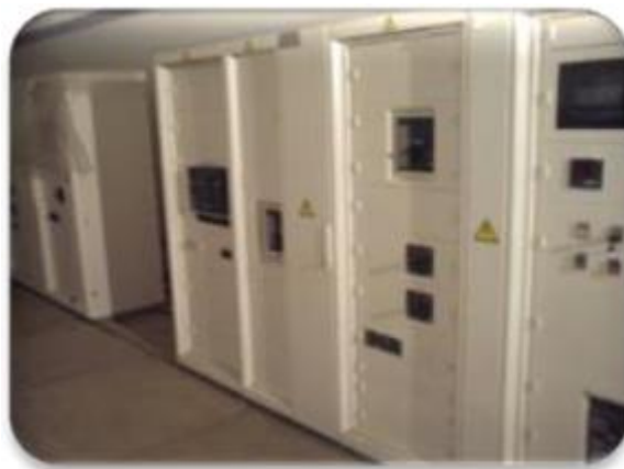
Рисунок 2.2 – Стаціонарна шафа керування
