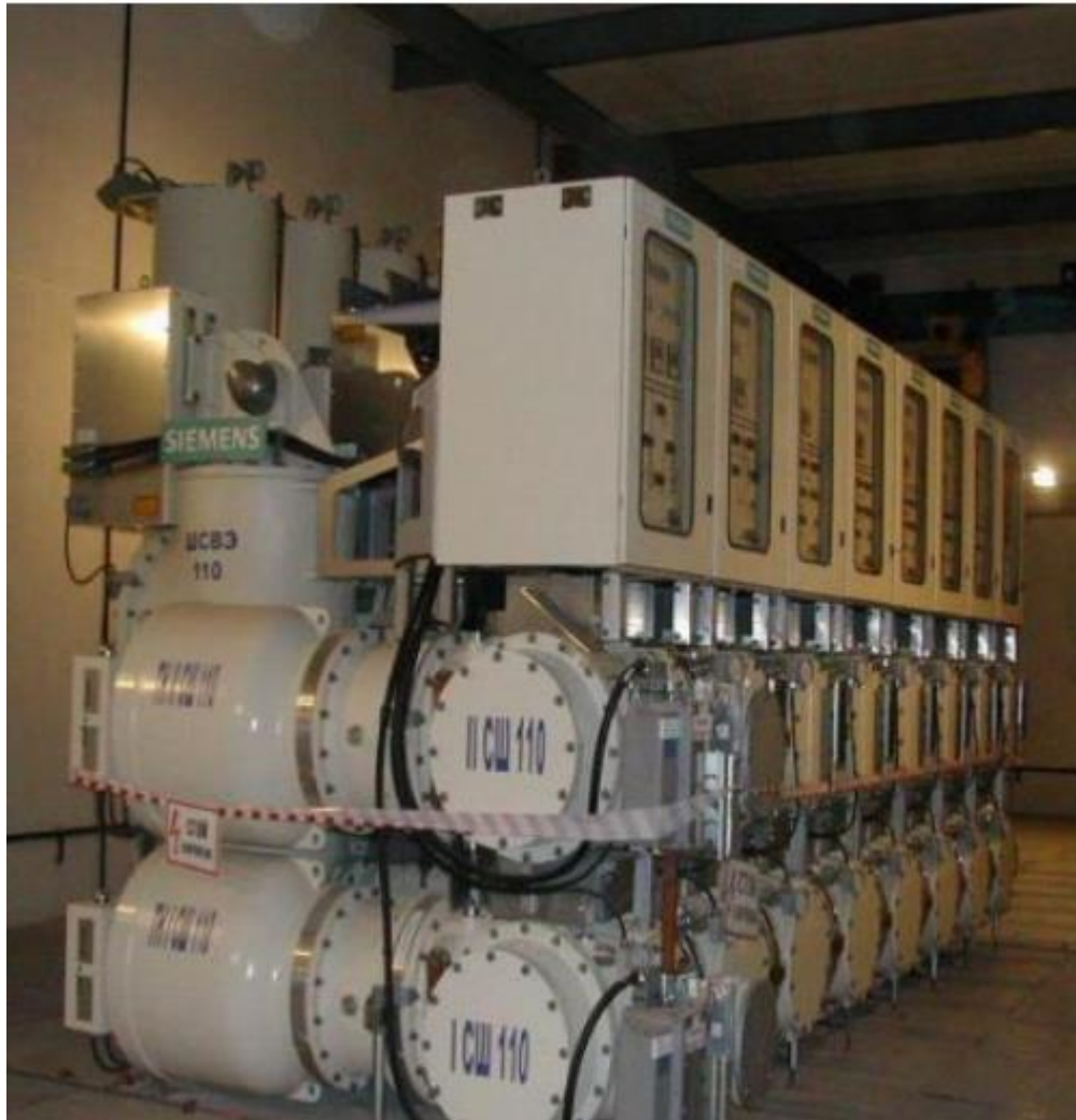
Рисунок 3.3 - КРУЕ 110 кВ серії 8DN8 (Siemens)
