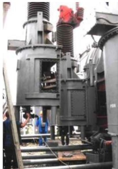
Рисунок 1.3 – Ремонт реактора та РПН автотрансформатора
