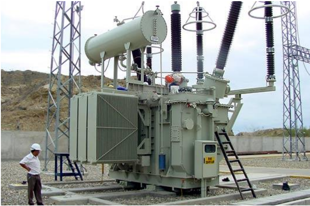
Рисунок 1.5 – Пошкоджений реактор 750 кВ
