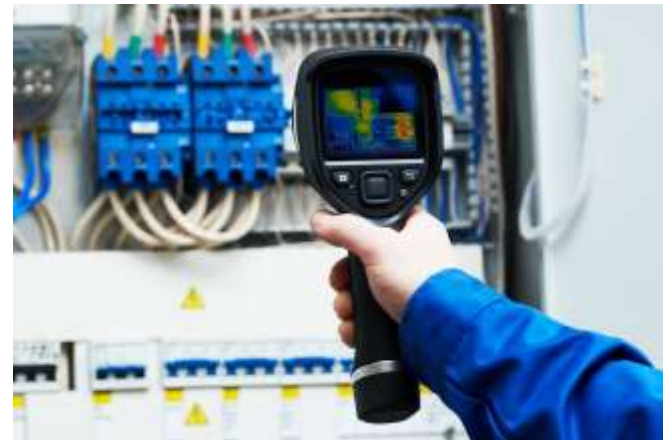
Рисунок 1 – Кольорове теплове зображення отримане за допомогою тепловізора
