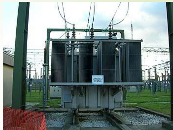
Рисунок 1 -Трифазний струмообмежувальний реактор в лінії 110 кВ, номінальною реактивною потужністю 50 МВАр
