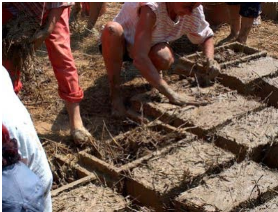
Рисунок 1.1 – Формування композитного будівельного матеріалу у формі цегли
