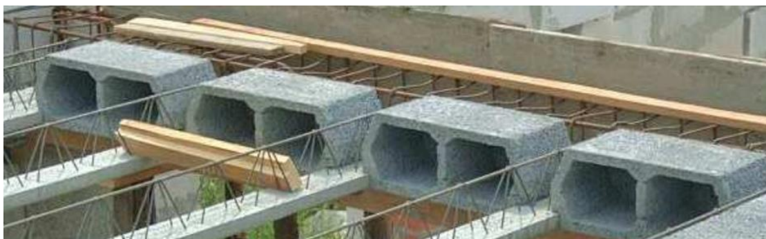
Рисунок 2.1 – Конструкція збірно-монолітного перекриття «TERIVA»
