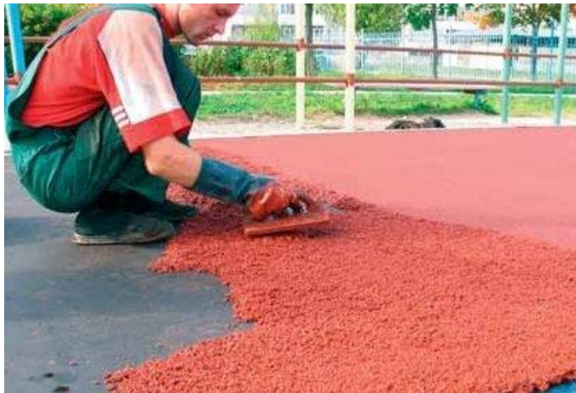
Рисунок 3.2 – Улаштування безшовного резинового покриття велодоріжки
