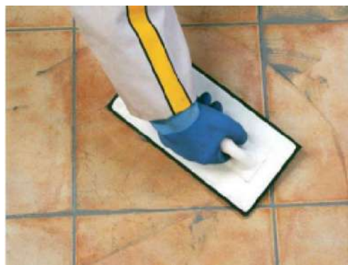
10 - заповнення міжплиточних швів
