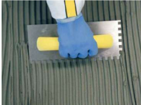
7 - нанесення клейової суміші;
