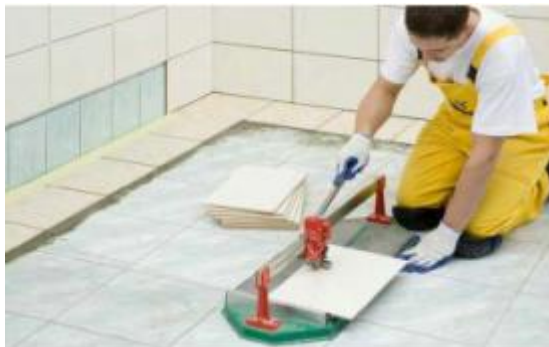
Рисунок 3.3 – Розрізка плиток
