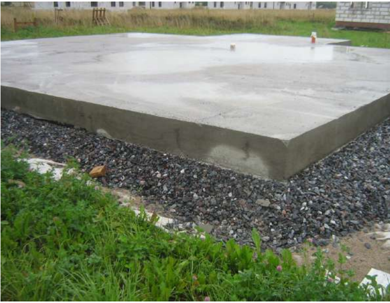
Улаштування фундаментної плити монолітної
