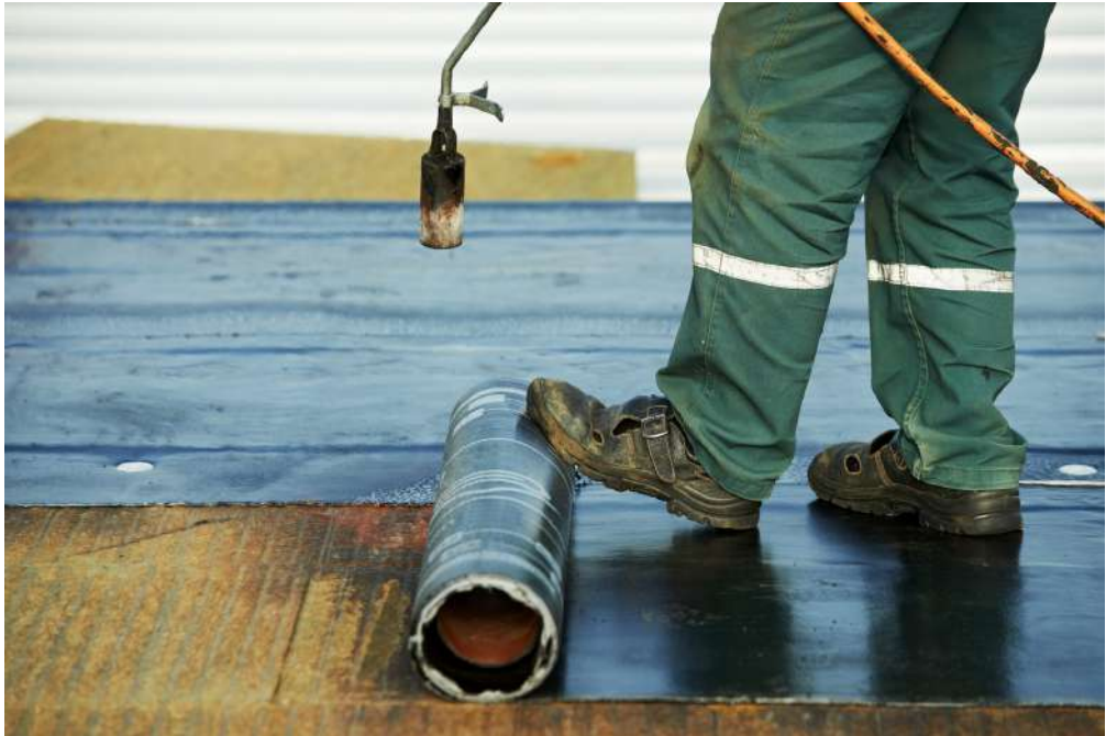
Улаштування покрівель із бітумної мастики
