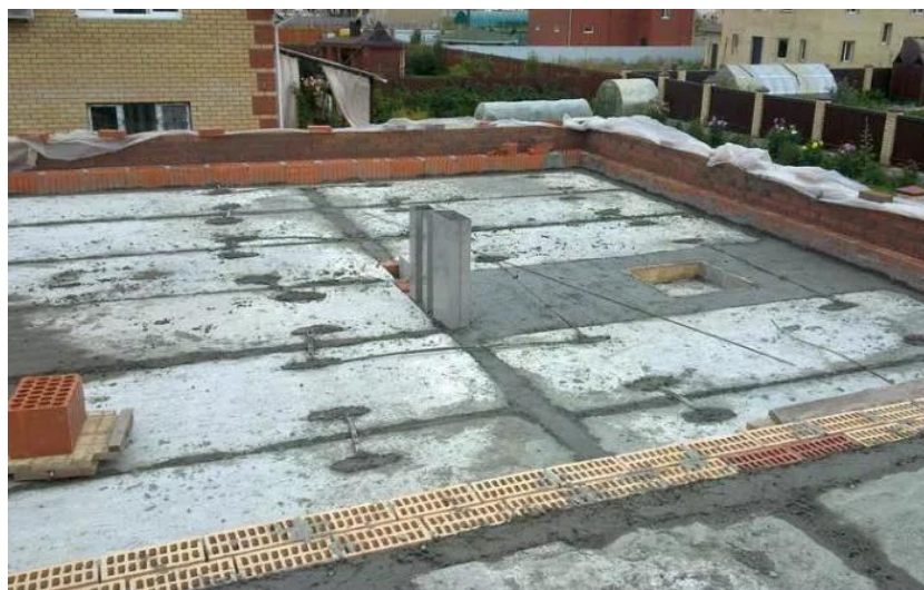
Рисунок 4.7 – Перекриття із закладеними швами
