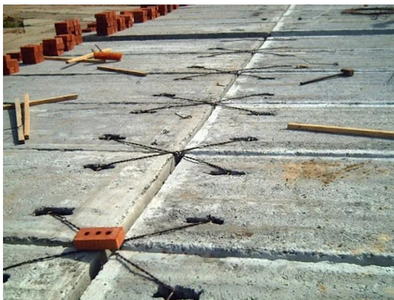
Рисунок 4.5 – Анкерування плит перекриття між собою
