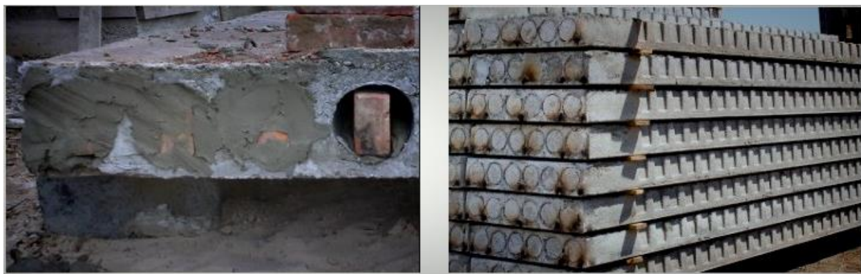
Рисунок 4.3 – Герметизація торців пустот плит перед моонтажем
