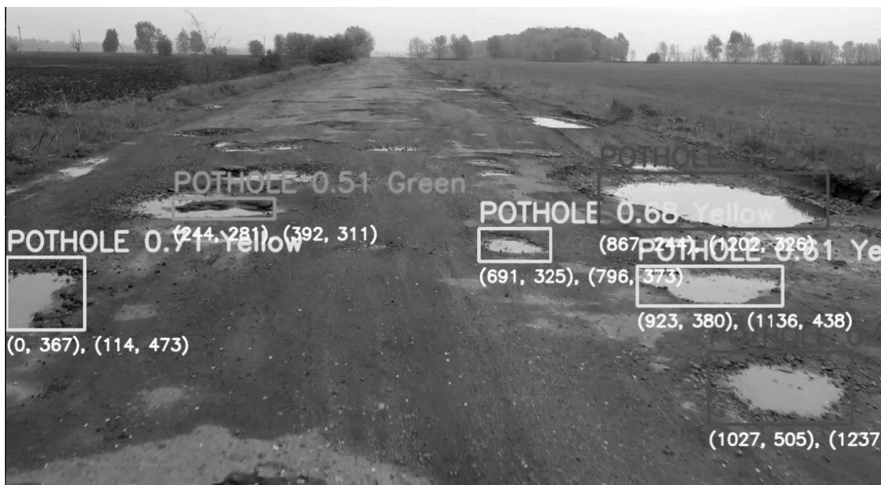
Рисунок Г.3 — Результат роботи програми для виявлення пошкоджень на комбінованому дорожньому покритті
